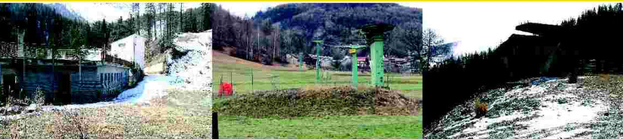
DA SX. A DX. (FOTO 4, 1, 3): "UN EDIFICIO ABBANDONATO - I TRALICCI NEI PRESSI DELL'ABITATO DI BEAULARD - LA STAZIONE DI ARRIVO DELLA STAZIONE DI BEAULARD"
